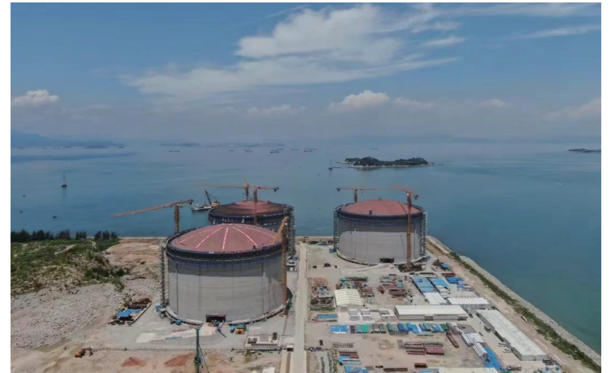
> 广东能源集团有限公司惠州 LNG 接收站项目现场
