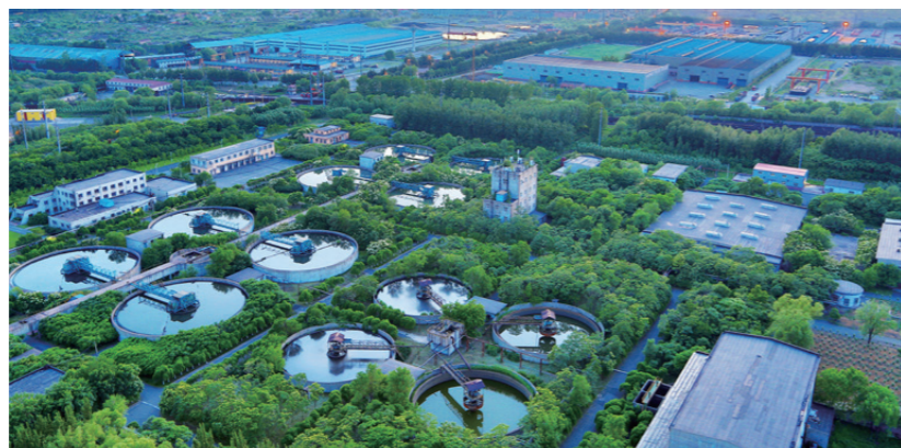
> 公司能环管理中心污水处理
