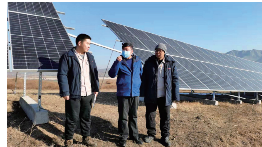
> 援建的朝阳市上桃村光伏项目
